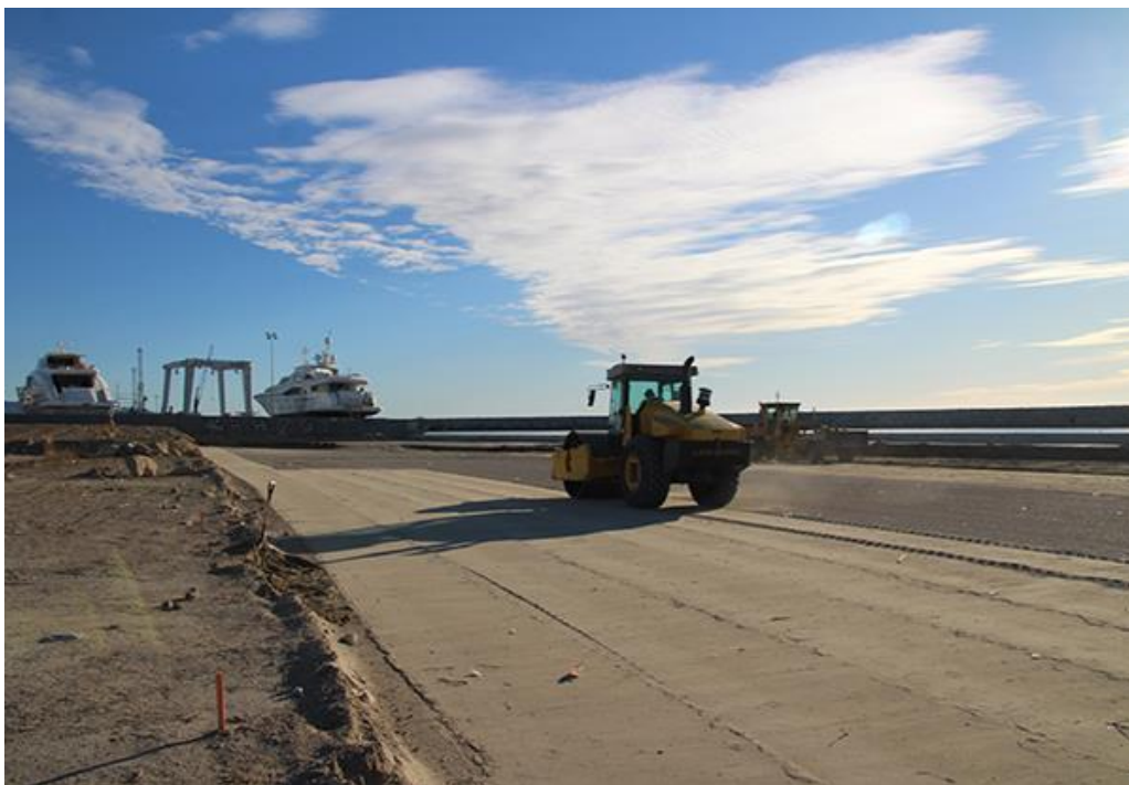
Les obres de Pendennis avui al port de Vilanova.
