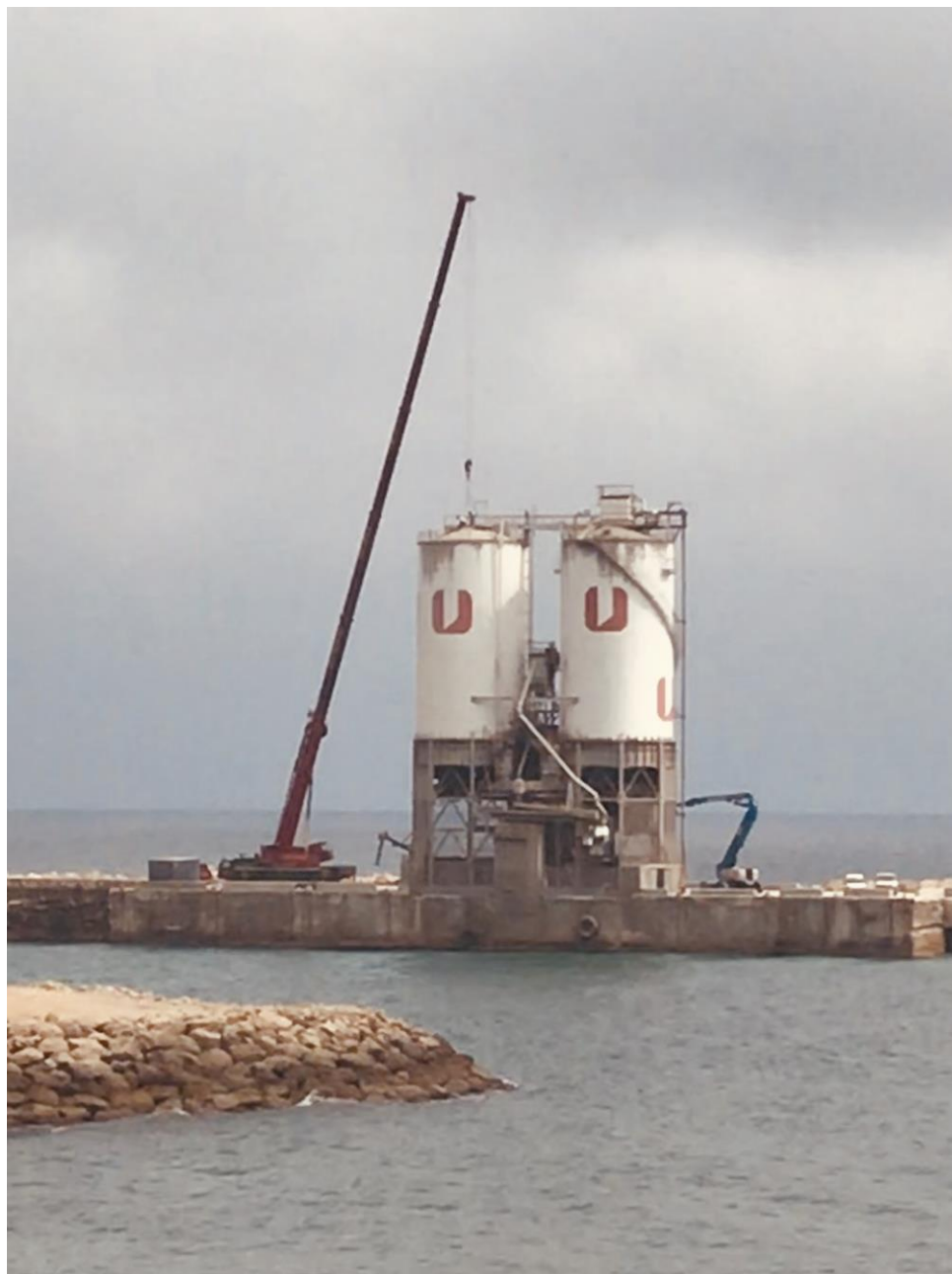
Desmuntatge de les dues sitges al port de Vallcarca.
