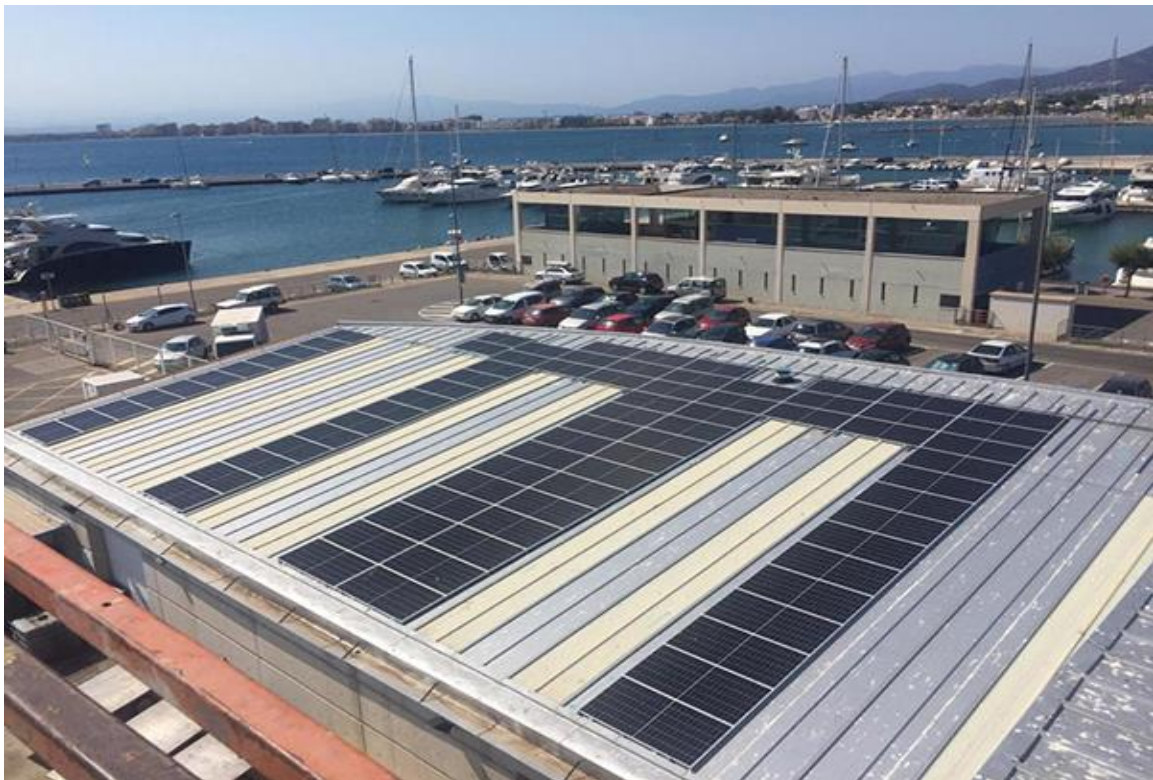
Instal·lació de plaques fotovoltaïques a la llotja de peix de Roses.
