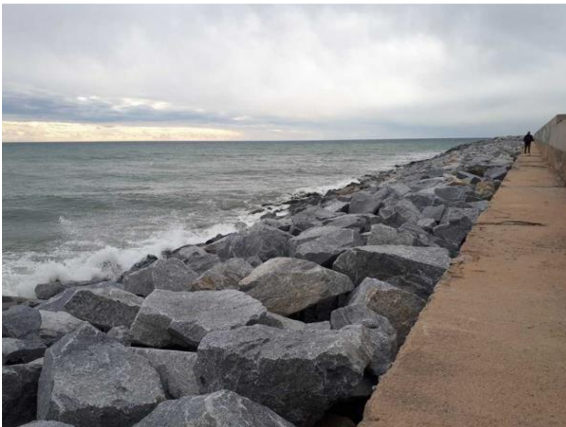
Obres de reforç del dic de recer acabades.
