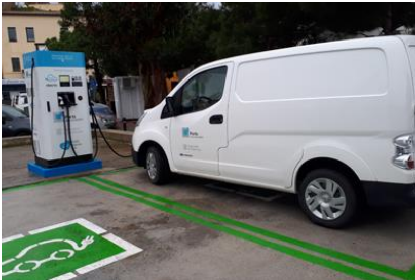
Punt de recàrrega de vehicles elèctrics al port de Palamós.
