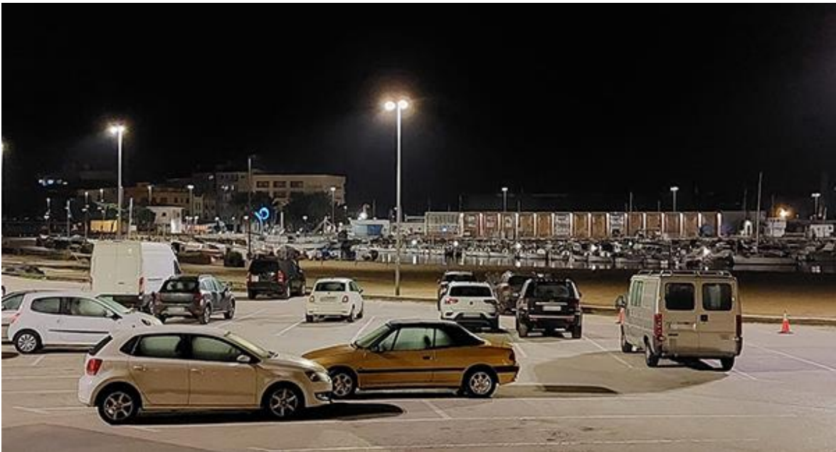
Nou enllumenat LED a l'aparcament de la Platja Gran de Palamós.
