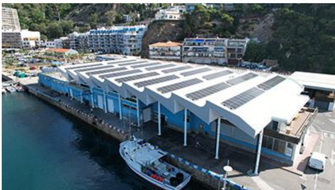
Nova coberta amb 200 plaques fotovoltaïques.
