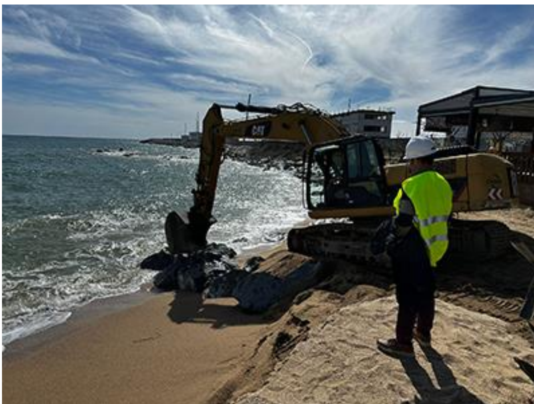
Col·locació d'escullera a la zona del Portinyol.
